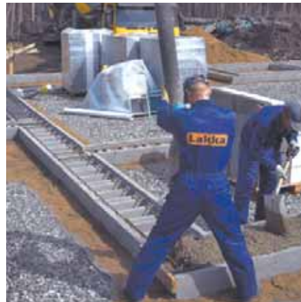
Заливка опорного фундамента (башмак) бетонной смесью
